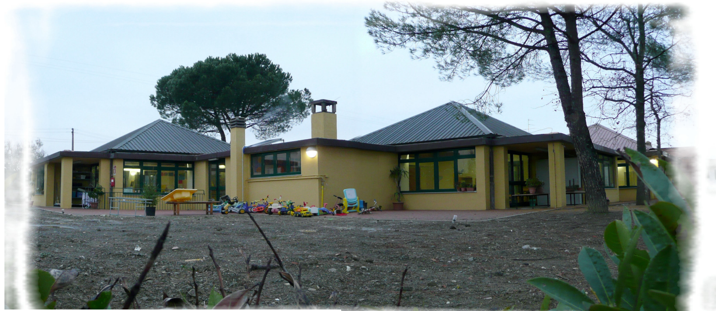
ADEGUAMENTO ANTISISMICO ED AMPLIAMENTO DELLA SCUOLA MATERNA COMUNE DI SAN CASCIANO IN VAL DI PESA LOC. CHIESANUOVA - ANNO 2007
